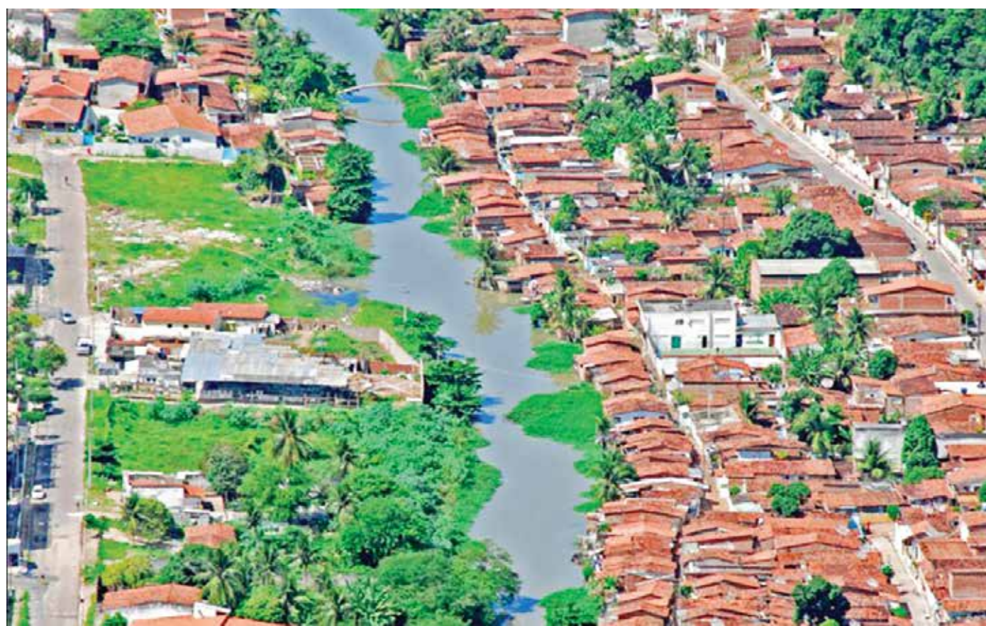
Uma das obras previstas pelo novo Plano Diretor de JP é a construção de uma ponte no Rio Jaguaribe, no bairro São José
